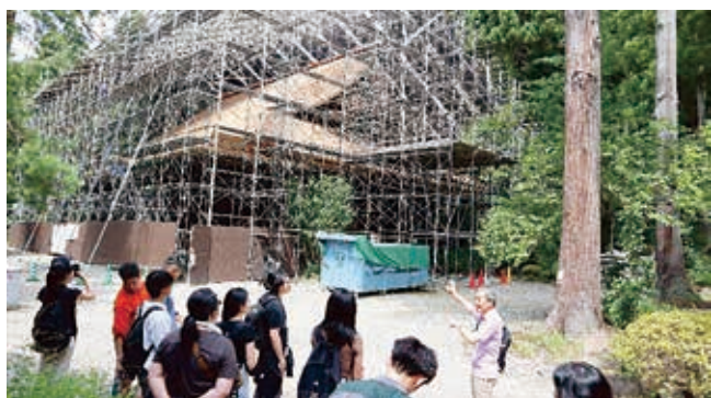
慈恩寺の耐震・雪害対策について説明を受ける
